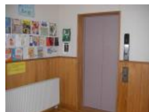
エレベーター
