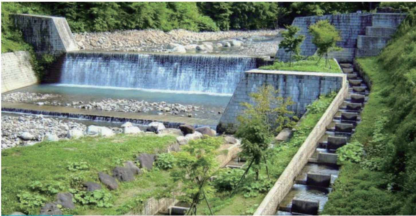
松川に造成された「松川第1砂防堰堤」。国立公園にあることから、環境や景観、生態系に配慮しています。付近には湯ノ又公園も整備されています
