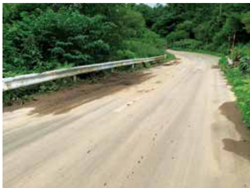
大雨により、道路に流れ出した土砂 (七時雨カルデラライン田代平付近)
