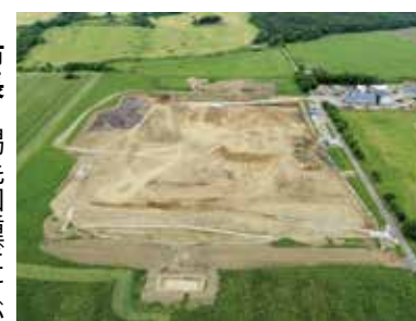
進むキャトルセンター造成工事
