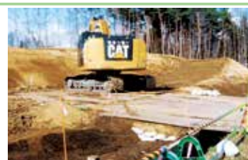
着々と進む保育所建設工事
