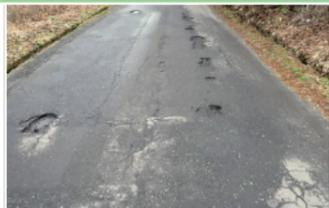
冬季間の凍結による陥没ひび割れ
