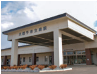
建設工事が完了し、開院に向けた準備を進めている市立病院
