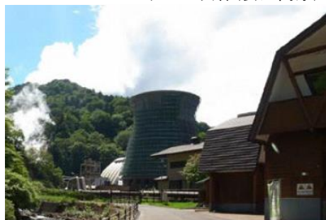
松川地熱発電所
