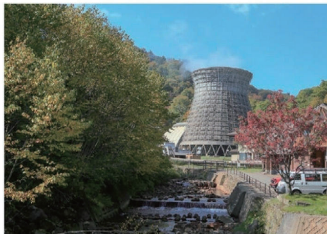
松川地熱発電所は、1966(昭和41)年に運転を開始した日本で最初の地熱発電所。地熱エネルギーを利用しているため、自然環境に与える影響が少ない発電施設です
