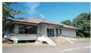
八幡平市松尾鉦山資料館
