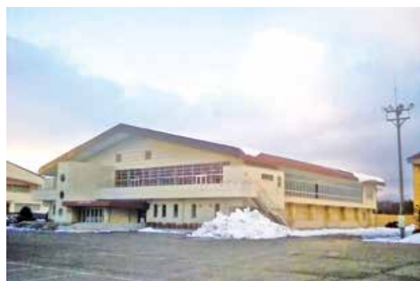
老朽化が進む西根地区体育館
