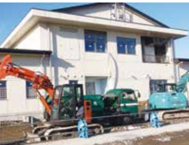
完成間近の新市立病院建設工事
