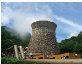
松川地熱発電所
