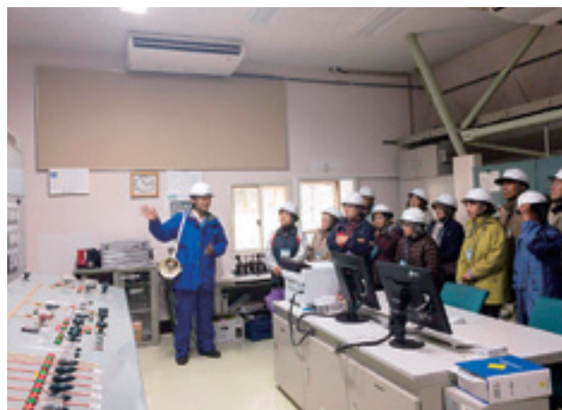
松川地熱発電所の制御室で説明を受ける参加者
