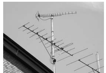
UHFとVHFの混合型アンテナ(上がUHF、下がVHF)
