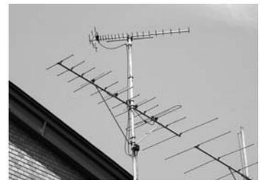
UHFとVHFの混合型アンテナ(上がUHF、下がVHF)
