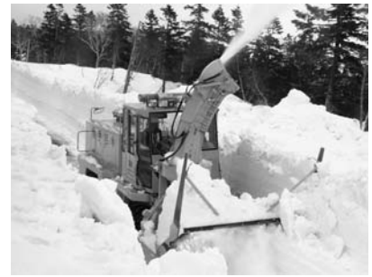
アスピーテライン除雪作業
