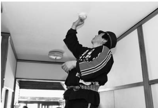
住宅用火災警報器を取り付ける消防団員
