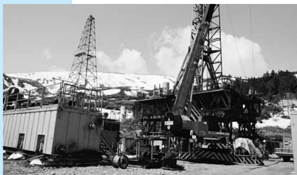
地熱発電調査のために行われている掘削作業
