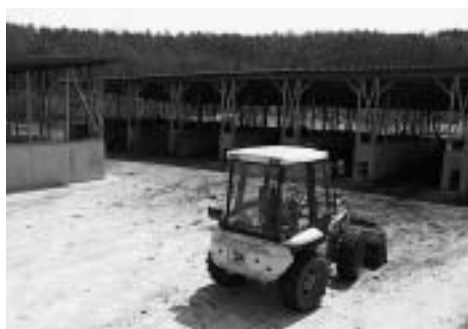
松尾・谷地中地区に整備している堆肥センター
