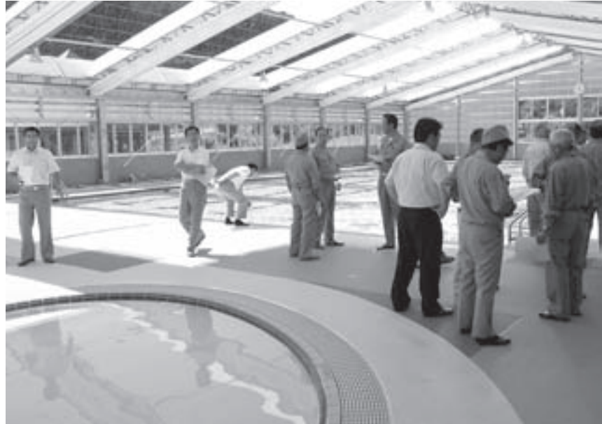
開閉式屋根を備える安代小学校プール
