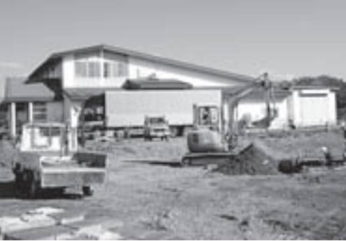
貸工場（写真奥）の隣では、道の駅にしねの駐車場を拡幅する工事が行われています
