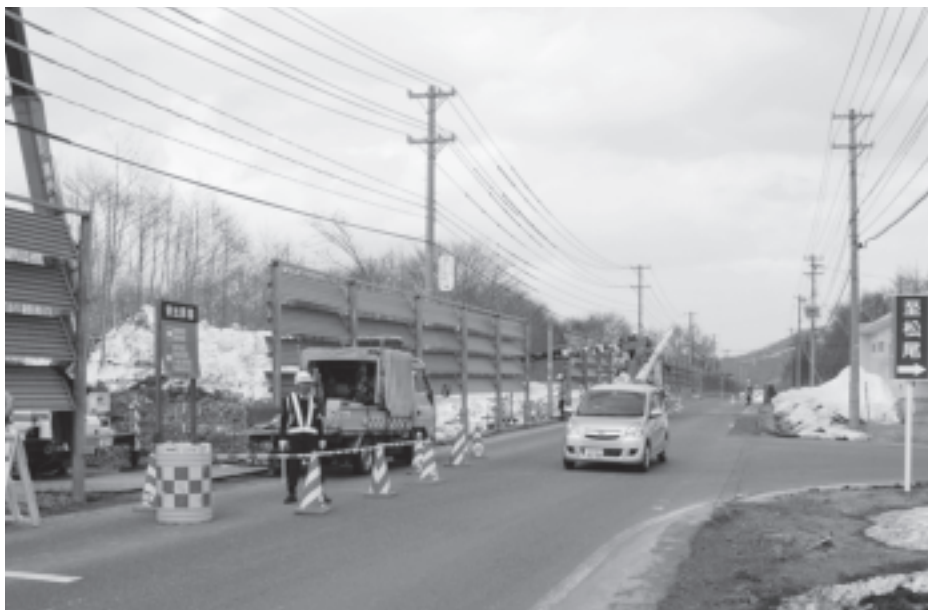
改良工事が始まった市道前森山線（写真左側）
