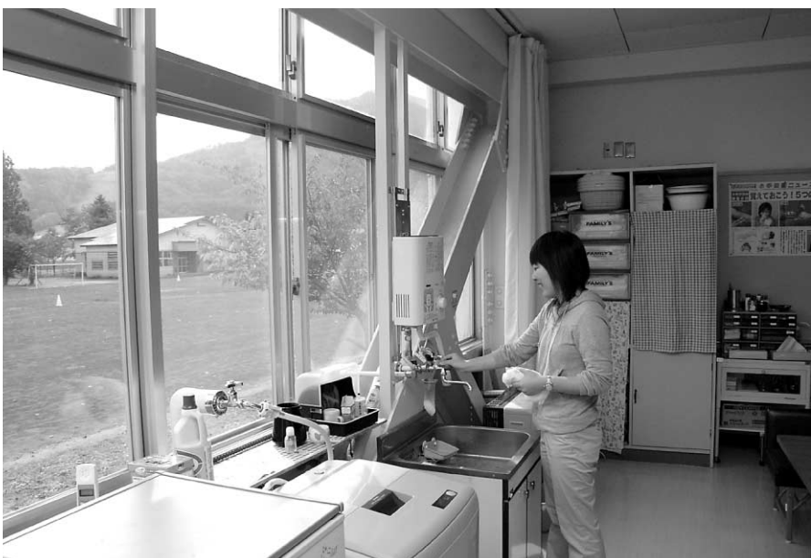
大規模改修工事で耐震補強が施された田山小学校
