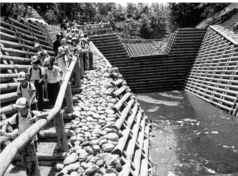
国が間伐材を利用して整備した砂防施設「岩手山焼走り床固め工群」
