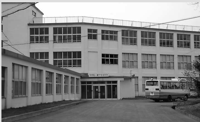
学習院八幡平松尾校舎。今後は学習院が解体することになります
