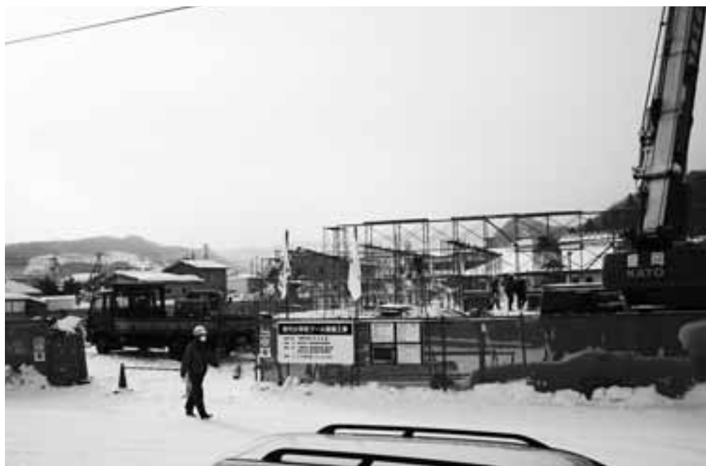
春の完成を旨として進む安代小のプール建設現場(市内清水地区)
