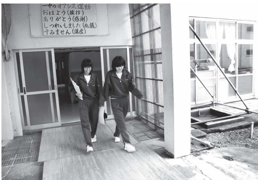
西根第一中学校（写真）などの耐震化を進めていきます
