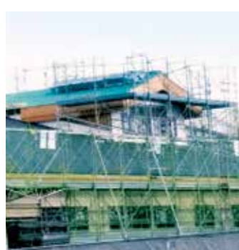
着々と進む 新市立病院建設工事
