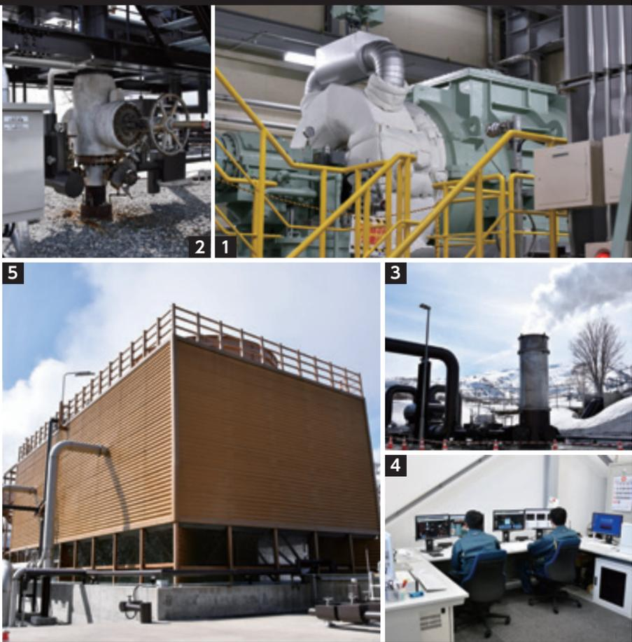
1蒸気タービン・発電機 2生産基地の坑井 3蒸気を大気に開放するサイレンサ 4装置や機械をコントロールする制御室 5復水器から出る温水を冷却する冷却塔 6上空からの全体写真(岩手地熱提供) 7開所式テープカット 8安全祈願祭
