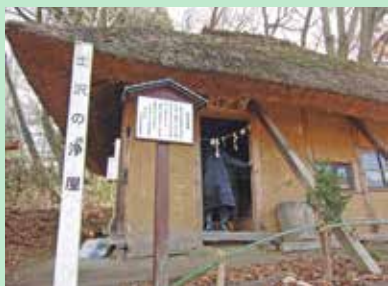
西根寺田の土沢浄屋
