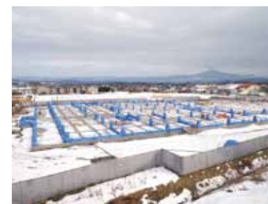
着々と進む新市立病院建設
