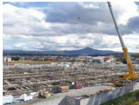
着々と進む新市立病院建設
