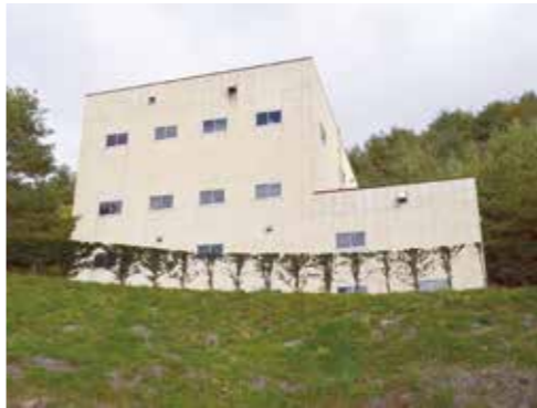
早期解体が望まれる旧ごみ焼却場
