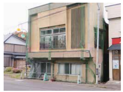
市内国道沿いの空家
