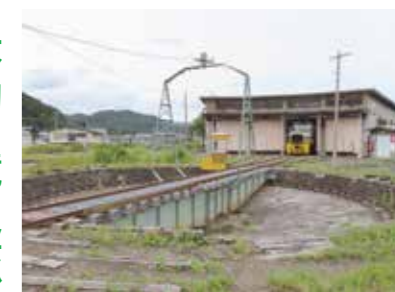
荒屋新町駅ドイツ製貨車転車台
