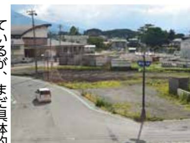
工事が進む大更駅周辺整備事業
