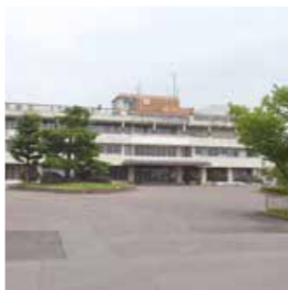
解体される旧松尾総合支所
