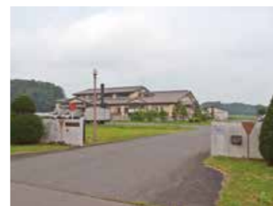
西根地区学校給食センター
