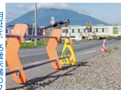
着々と進む道路改良工事(大更)
