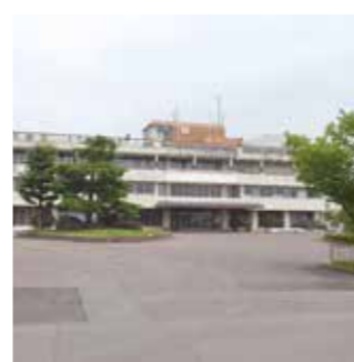
解体される旧松尾総合支所
