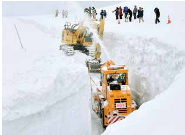
報道公開されたアスピーテラインの除雪作業(4月5日)
