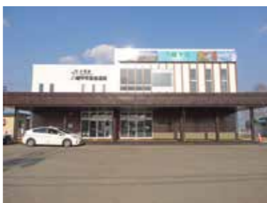
新築された大更駅舎と自由通路
