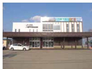
新築された大更駅舎と自由通路
