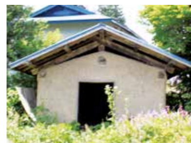
早期保存と活用を待つ岩屋塗室
