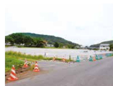
新病院建設工事現場
