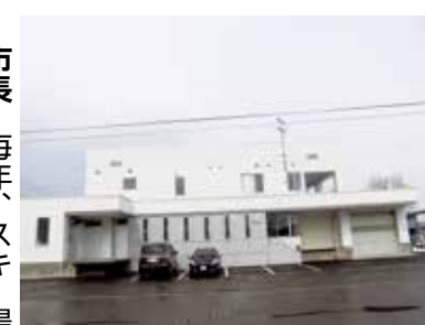
安代地区学校給食センター
