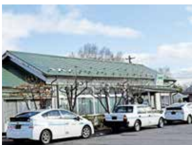
解体前の大更駅舎
