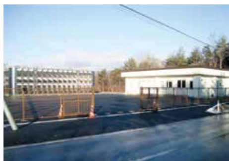
昨年完成した新小屋の沢配水池
