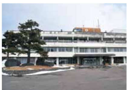
計画に基づき30年度に解体が予定されている旧松尾総合支所
