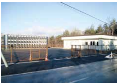
昨年完成した新小屋の沢配水池
