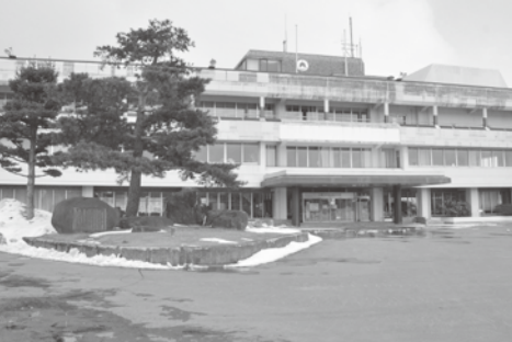
解体撤去が計画されている旧松尾総合支所
