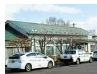
新築工事が始まったJR大更駅舎
