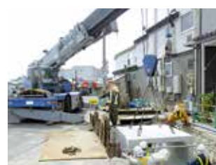
市発注工事現場
