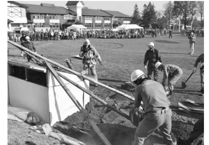
緊迫感漂う土砂災害倒壊家屋救助・救出訓練
