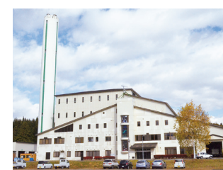
八幡平市清掃センター
