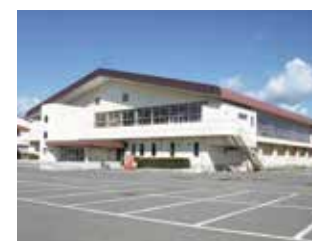
老朽化が進む公共施設
