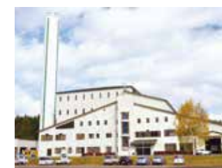
八幡平市清掃センター
