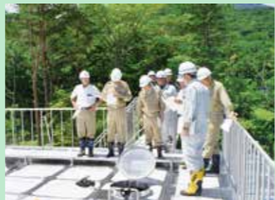
新小屋の沢配水池(7月12日)
