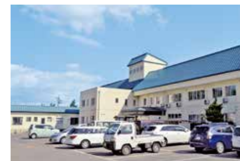
整備検討を進めている西根病院
