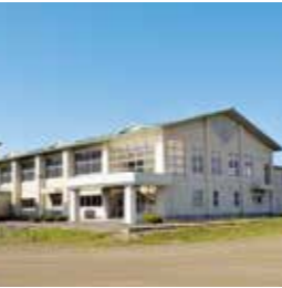
大更コミセン付属施設となった旧東大更小体育館
