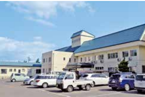
整備検討を進めている西根病院
