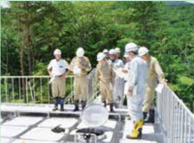
新小屋の沢配水池（7月12日）
