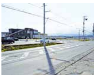
横断歩道がない北森駅前の国道
